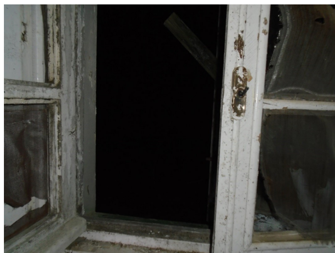
Foto del descenso al subterráneo de las calderas.
